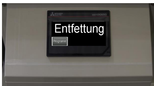
Prozessbedientableau zur Prozesssteuerung (Beispiel: Entfettung)
