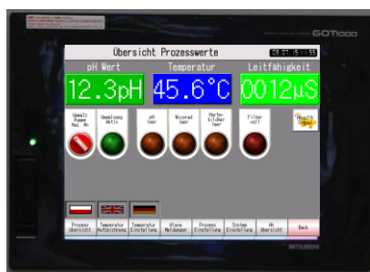
Einstellung und Überwachung der Badparameter vom Touchscreen-Bedienterminal (PRS-Steuerung)
